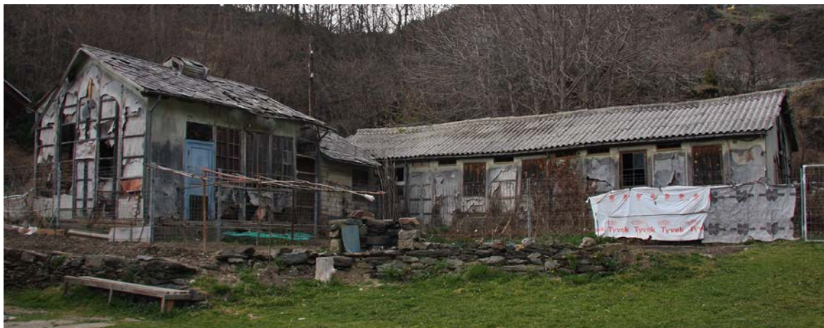
Fig.11 Estat actual de "l'hospital de cartó" de la Central de Capdella. Fotografia M. Remacha.
