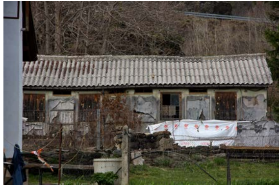
Fig. 22 La substitució de la teulada a l'ala de cures va propiciar que la seva conservació fos millor que la de l'ala de cirurgia. Fotografia S. Remacha.
