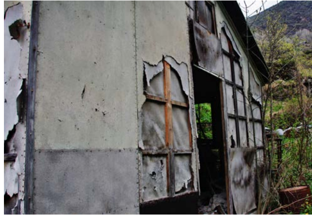
Fig.10 Es pot apreciar els materials constructius de l'edifici; cartó i fusta. Fotografia M. Remacha
