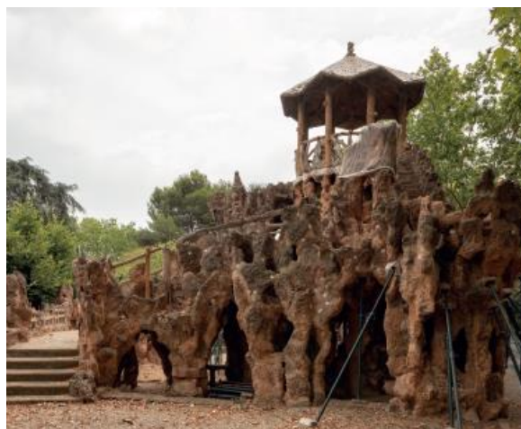
Viaducte del conjunt modernista de l'antic Manicomi de Sant Boi de Llobregat. Aleix Bagué.
