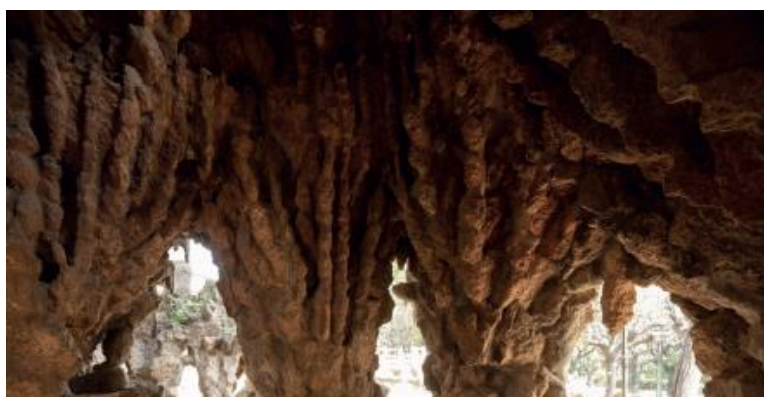
Estructura nervada del conjunt modernista de l'antic Manicomí de Sant Boi de Llobregat. Aleix Bagué.
