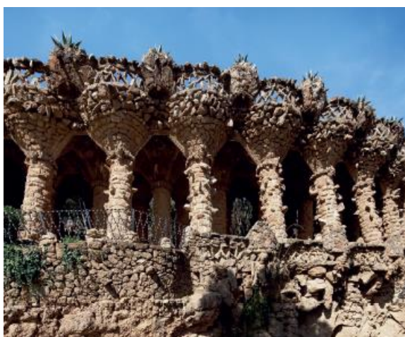
Viaducte del mig del Park Güell. Aleix Bagué.
