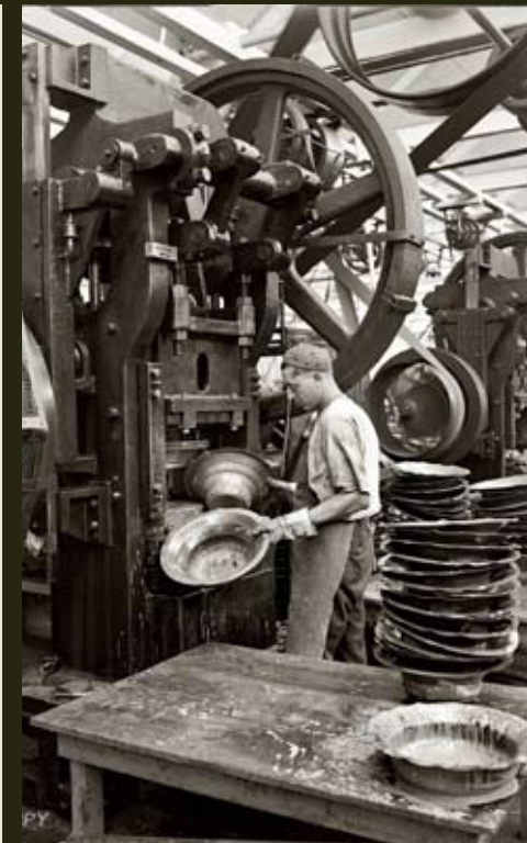
Estampación de trompetas de altoparlantes en la Fábrica de aparatos de radio Atwater Kent. Philadelphia, 1925. National Photo Company Collection, negativo sobre cristal. http://www.shorpy.com
