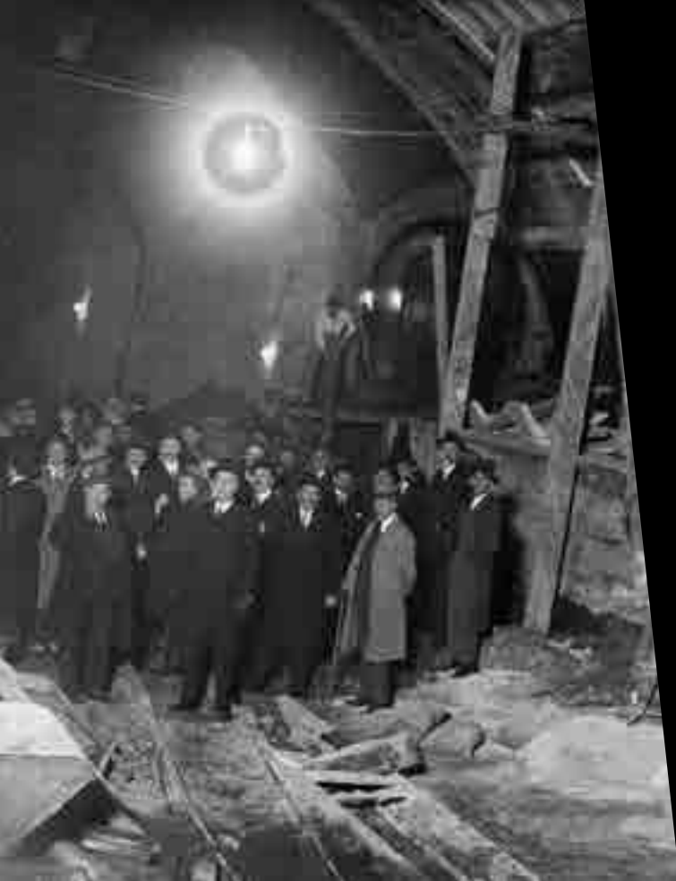
▲ Autoritats visitant les obres del metro transversal de Barcelona a l'estació de Rocafort (any 1925) (AFB-22-79)
