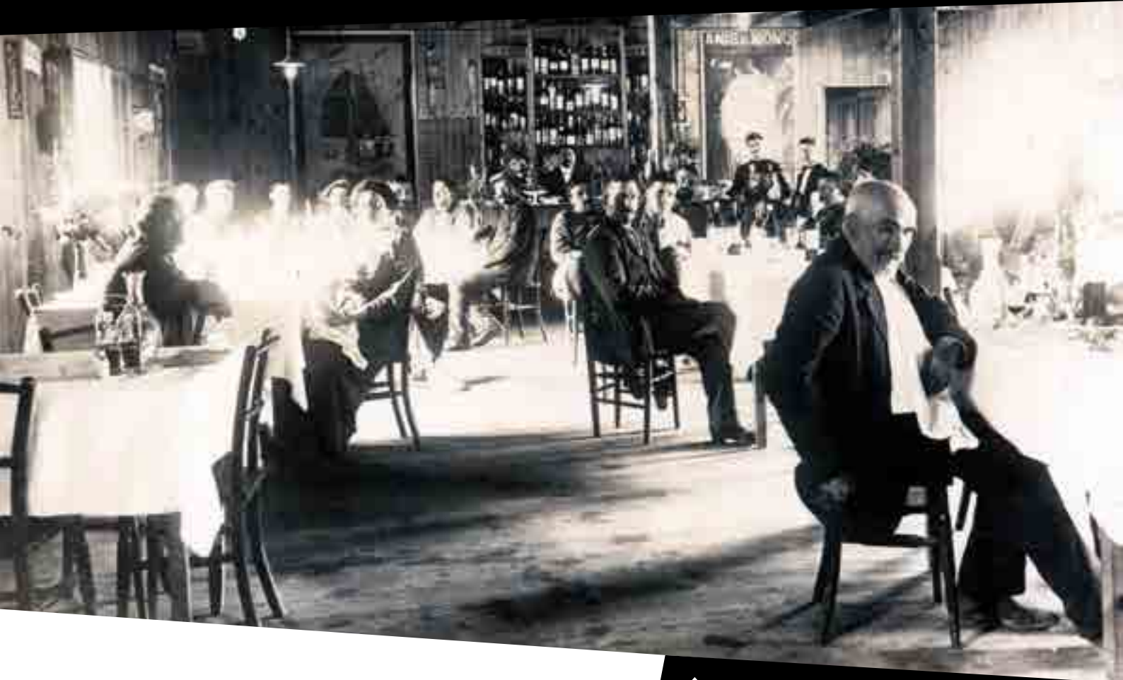
Interior de l'Hotel Energía de la Central de Capdella (Museu Hidroelèctric de Capdella)
