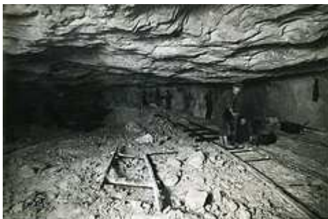
Col·locació de les vies a la mina.
