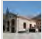
MUSEU HIDRO- ELÈCTRIC DE CAPDELLA
