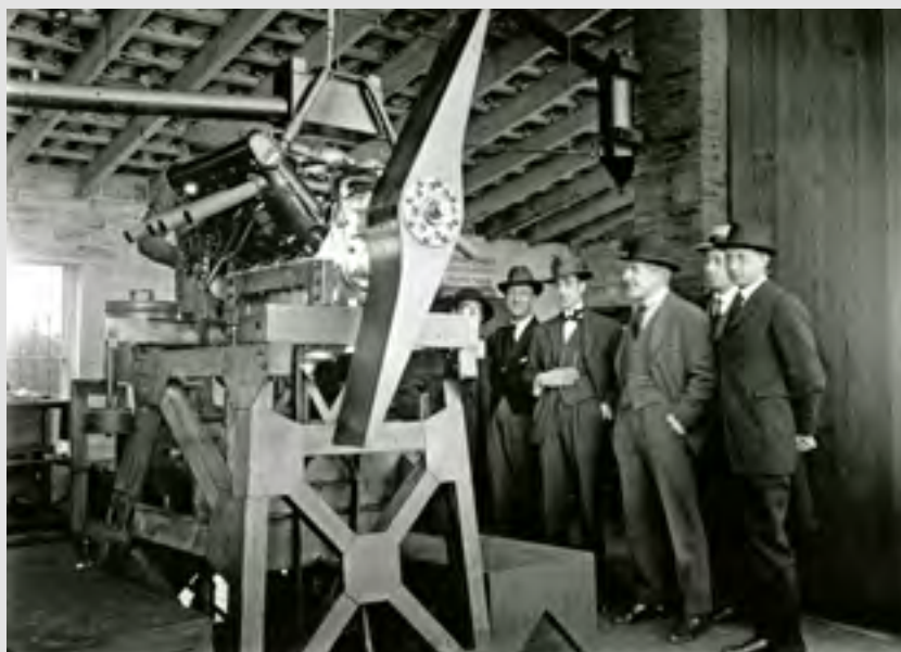
→ Prova d'un motor V8 a la fàbrica d'Hispano-Suiza de la Sagrera, 1918
