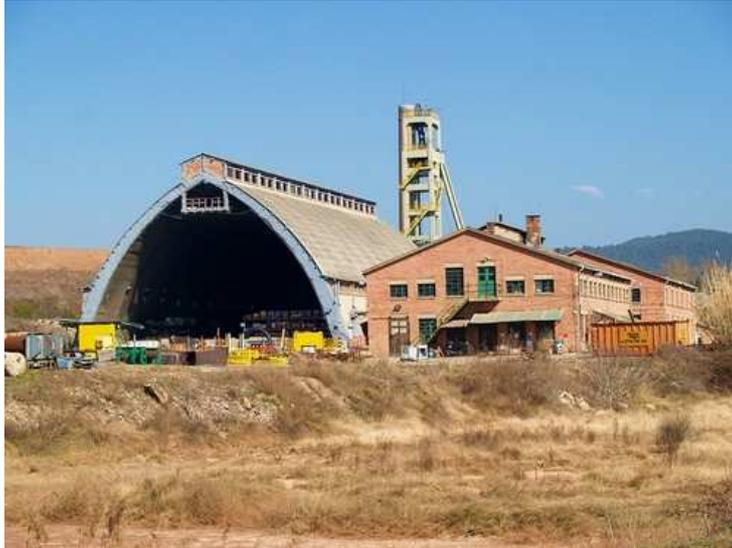
*Nave con arco parabólico y castillete de hormigón en la mina de Vilafruns-Balsareny*
